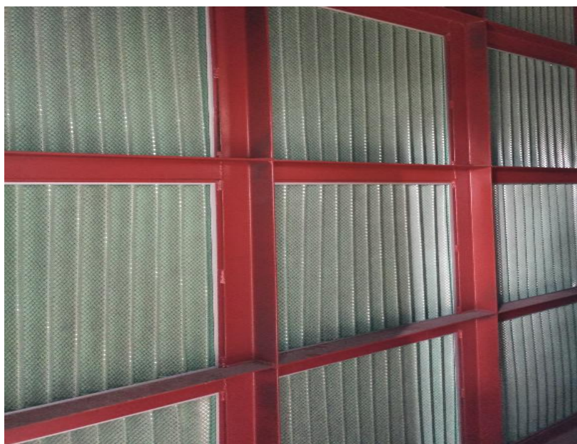
图 6.3-4 过滤装配内部结构图
